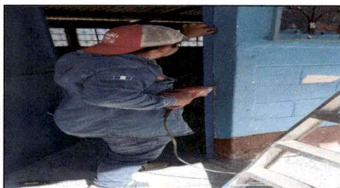
Foto 3: Instalación de puerta de metal (Módulo No. I)
