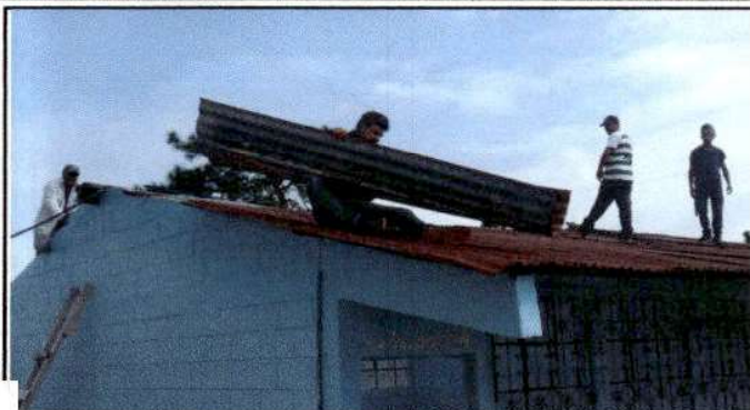
Foto 1: Sustitución de lamina por lamina aluzinc calibre 26
