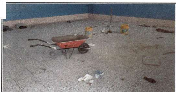
Foto 5: Sustitución de piso torta por piso granito (Aulas)
