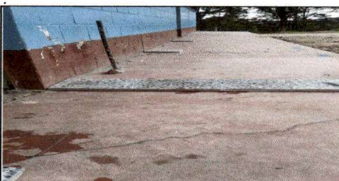
Foto 6: Sustitución de piso torta por piso granito (Corredor)
